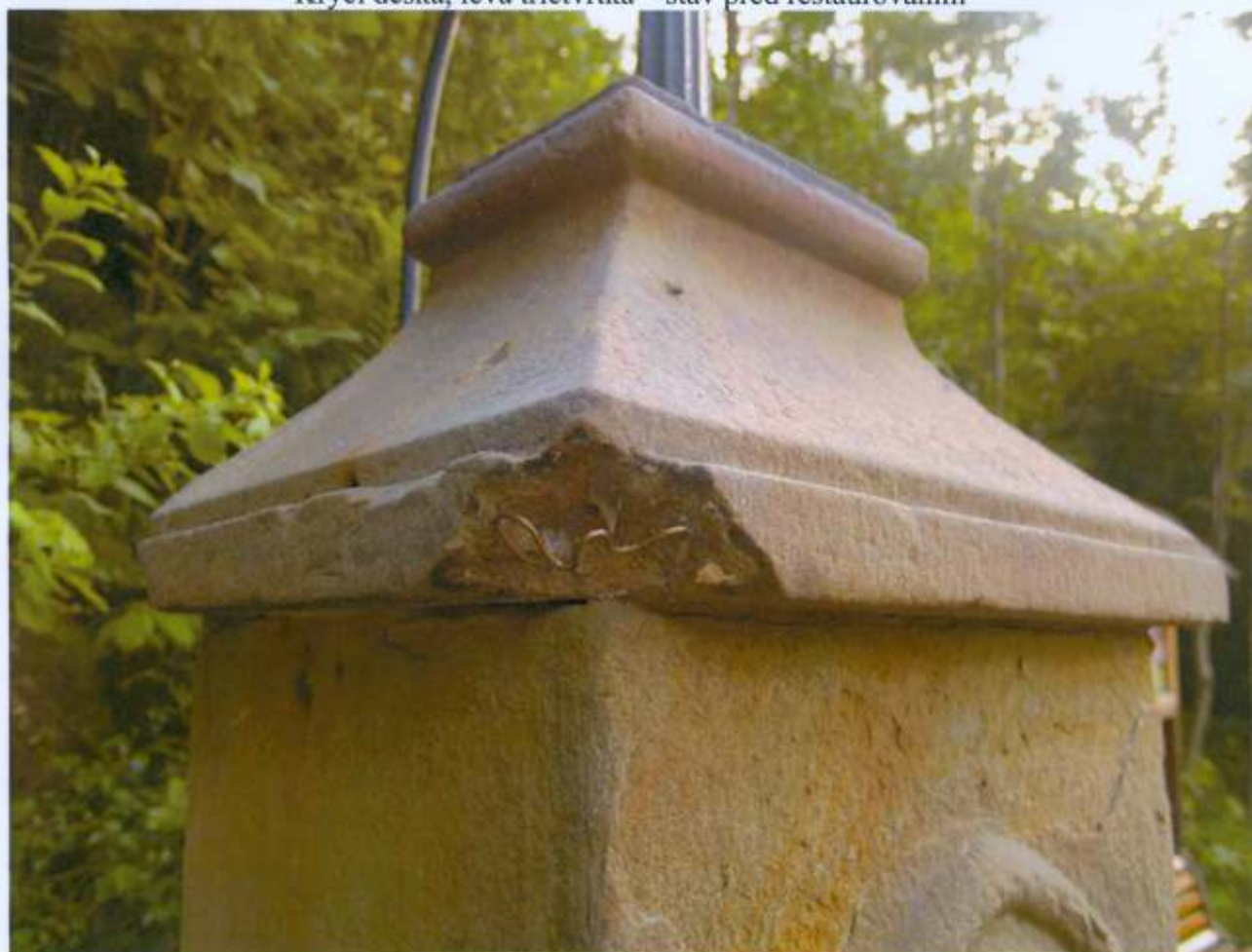
Krycí deska, levá třičtvrtka – stav po očištění, zpevnění, injektáži a vsazení armatur
