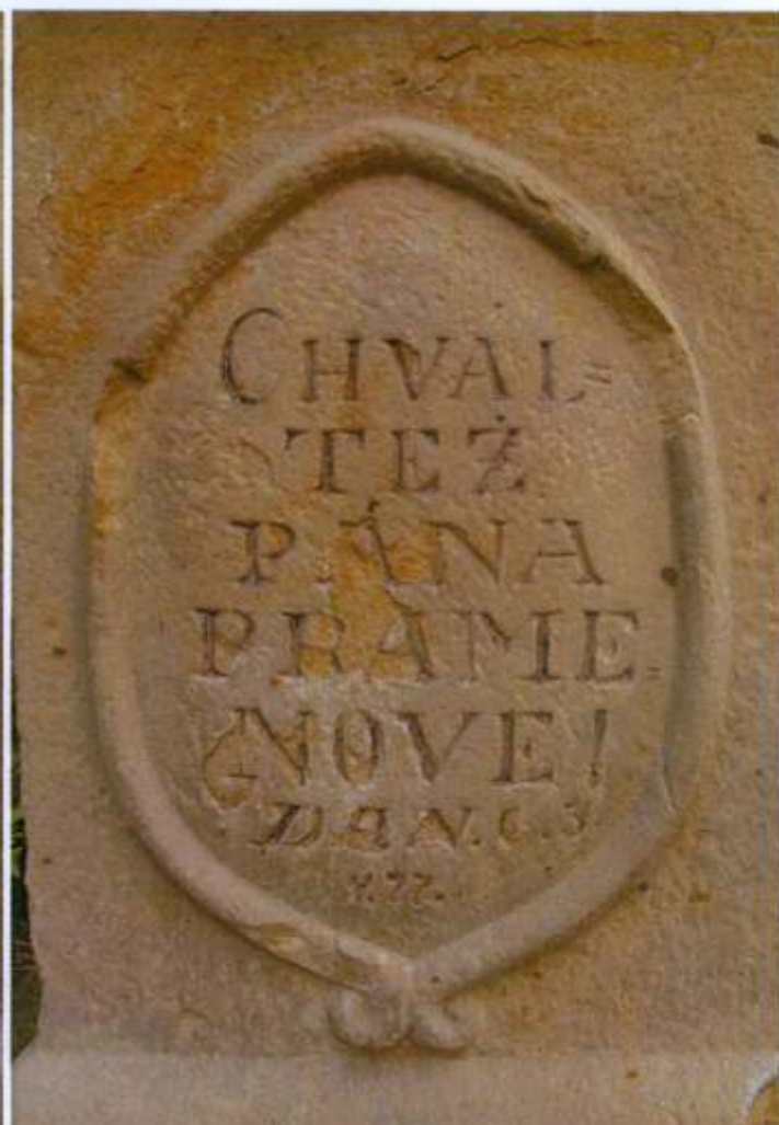
Stav po zpevnění
