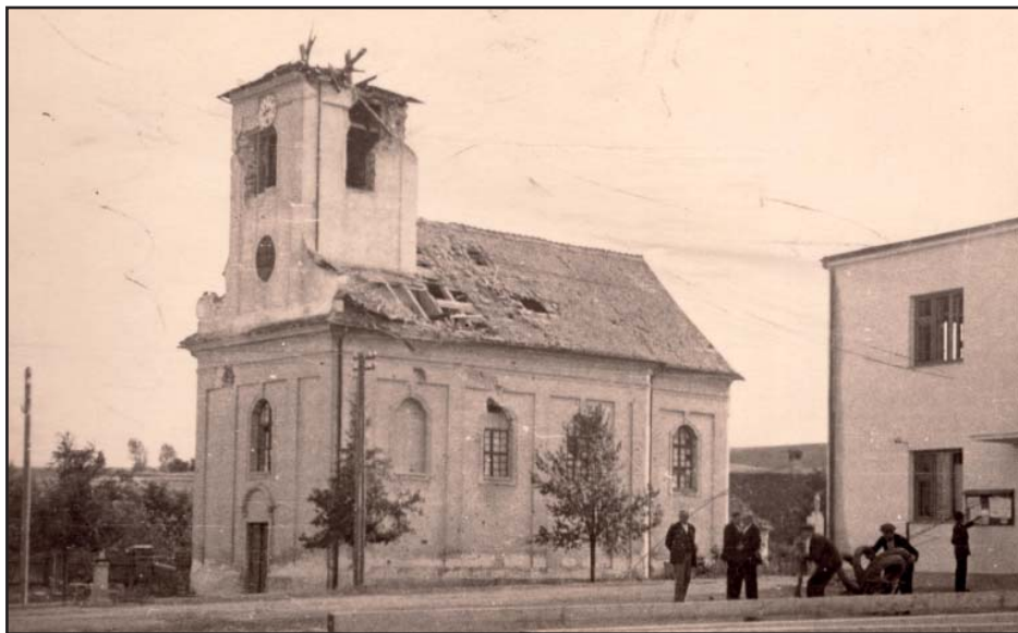
Těžce poškozený kostel v r. 1945
