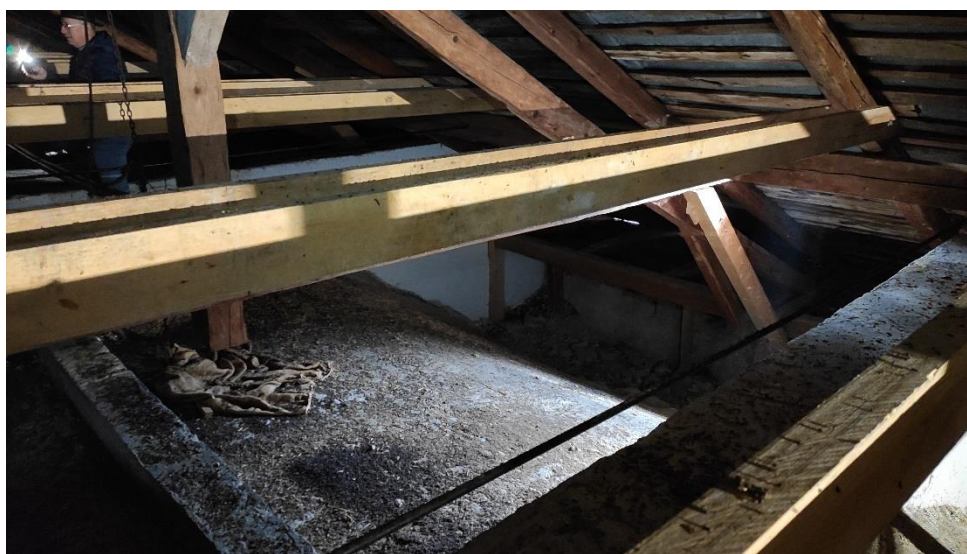
Obr.44 – Obnovené drevené prvky krovu.
