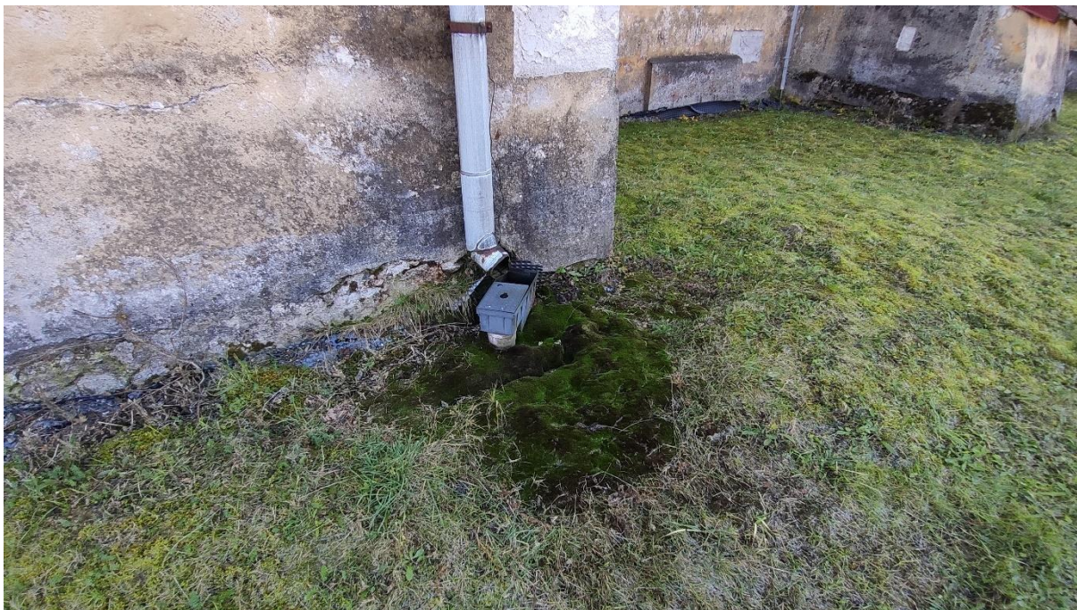
Obr.15 – Plocha s porastom machu dotovaná vodou zo zvodu Z2.
