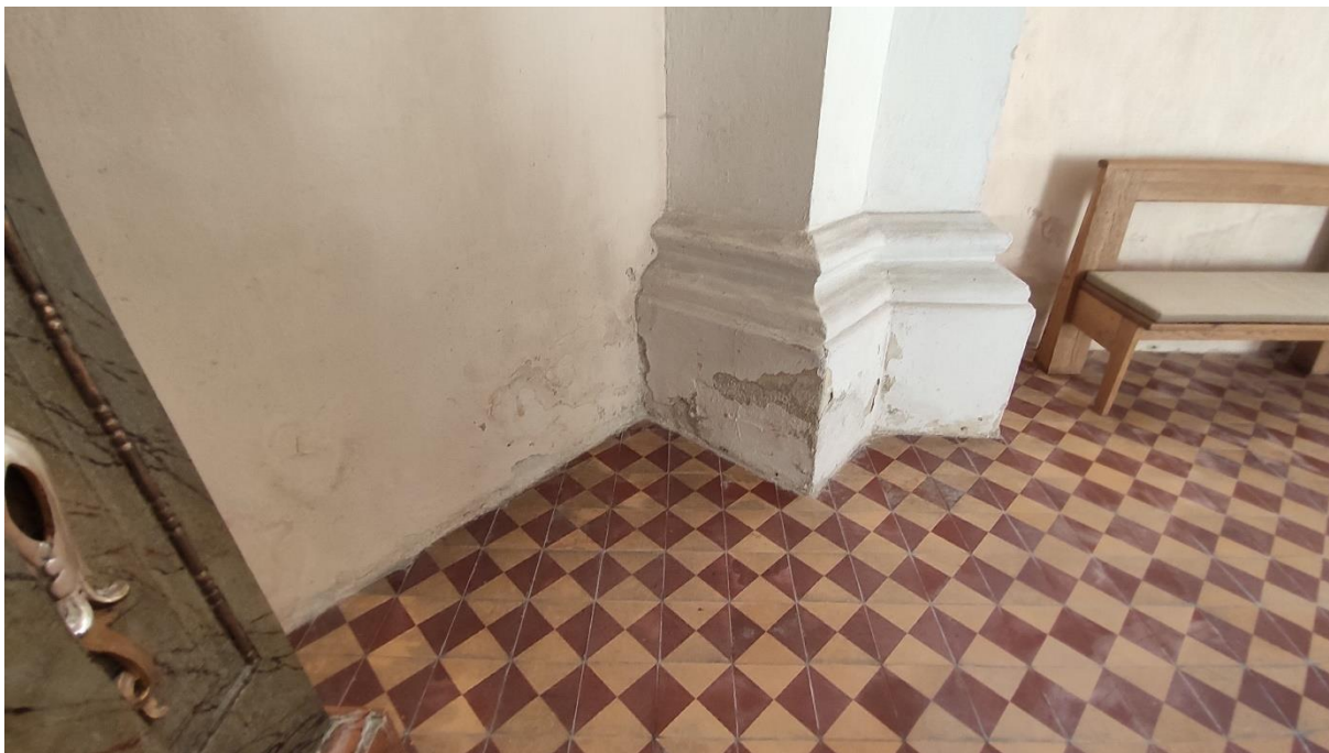
Obr.36 – Degradácia omietky pilastra vo svätyni kostola.
