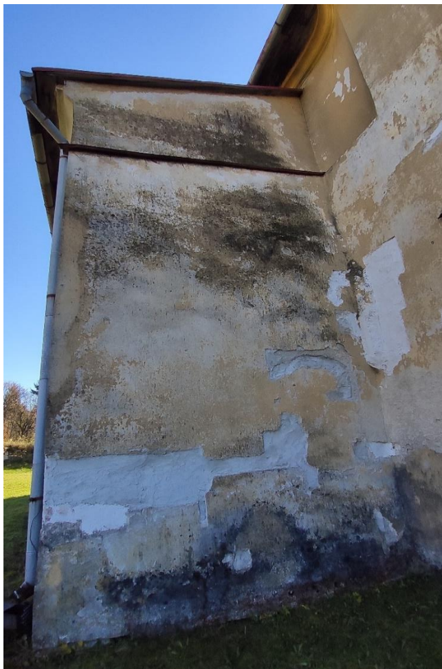
Obr.17,18 – Čierne povlaky na plochách zmáčaných dažďom.
