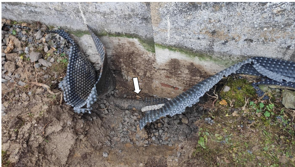
Obr.24 – Sonda č.1 na severnej strane kostola (drenáž osadená pri obvode muriva) .
