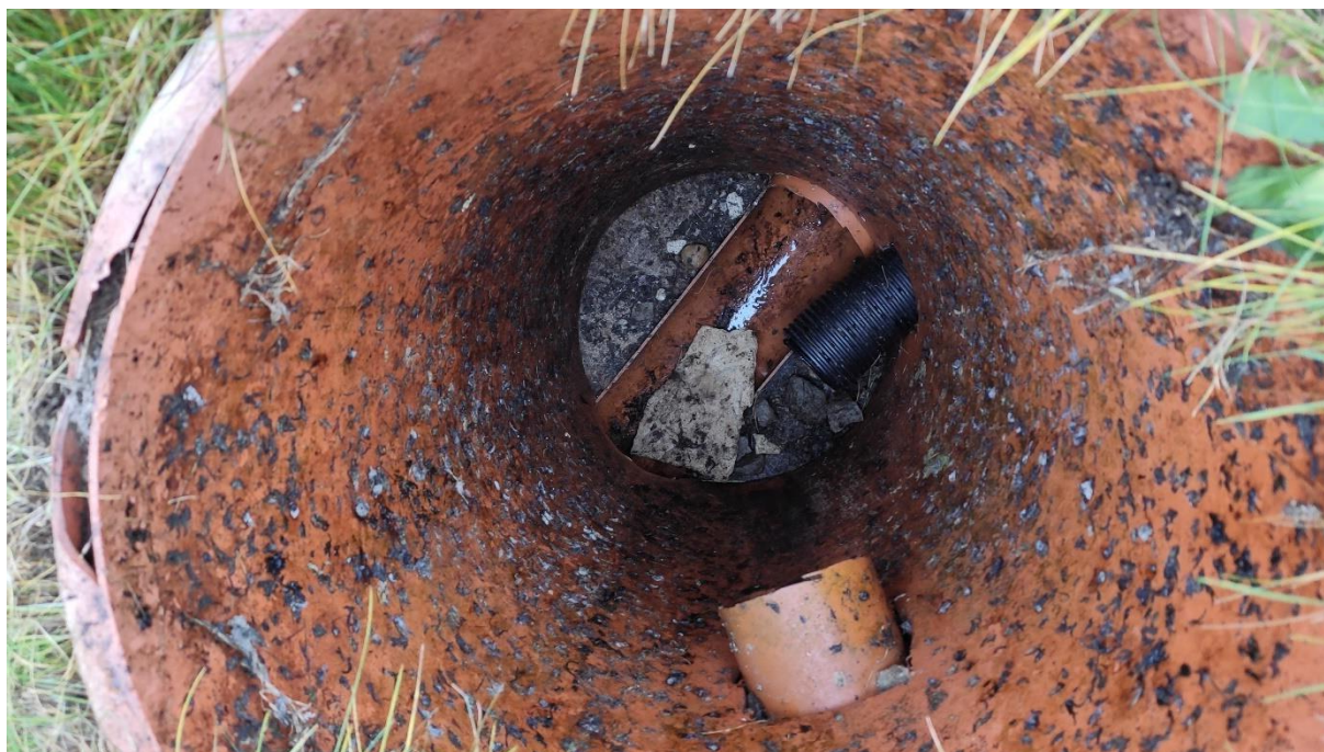
Obr.25 – Stav revíznej šachty SCH2.
