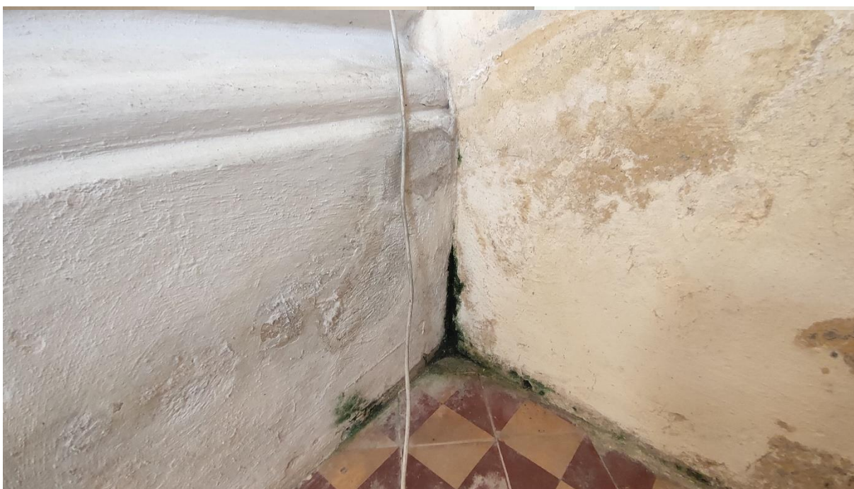
Obr.35 – V miestach potenciálnych tepelných mostov sa vyskytujú zelené povlaky.
