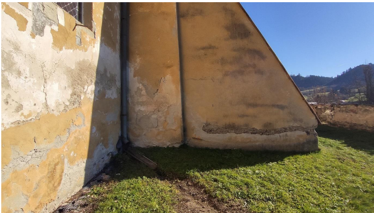
Obr.7 – Zmáčané plochy lode kostola a sekundárneho oporného múra.
