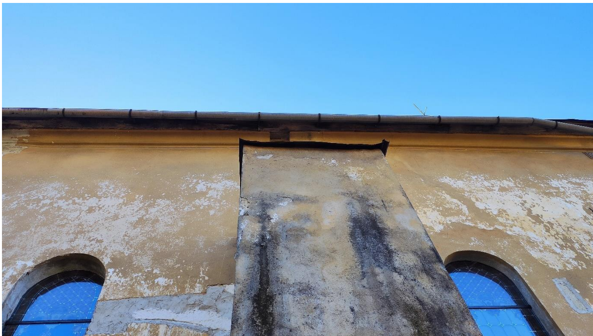
Obr.20 – Deponované plochy oporného piliera zatekaním z oplechovania.
