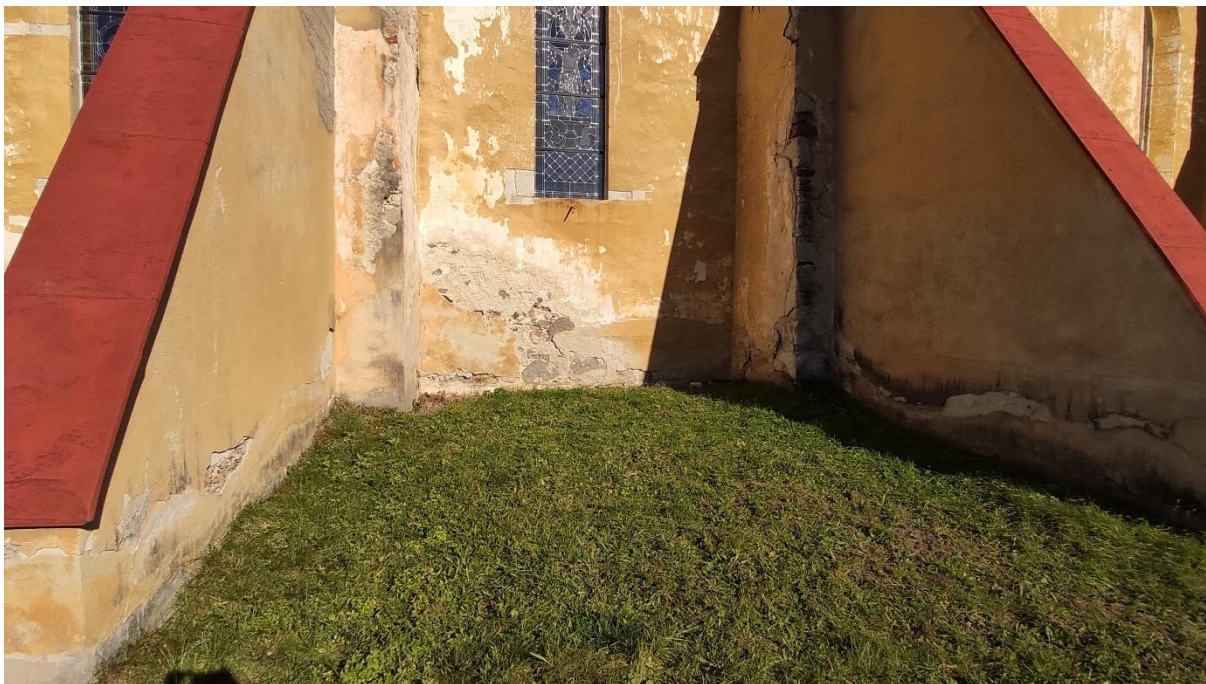
Obr.11 – Murivá v priamom kontakte s zatrávnenou plochou.
