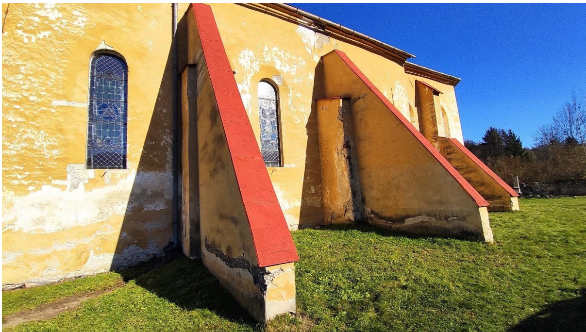
Obr.9 – Sekundárne realizované betónové oporné piliere.
