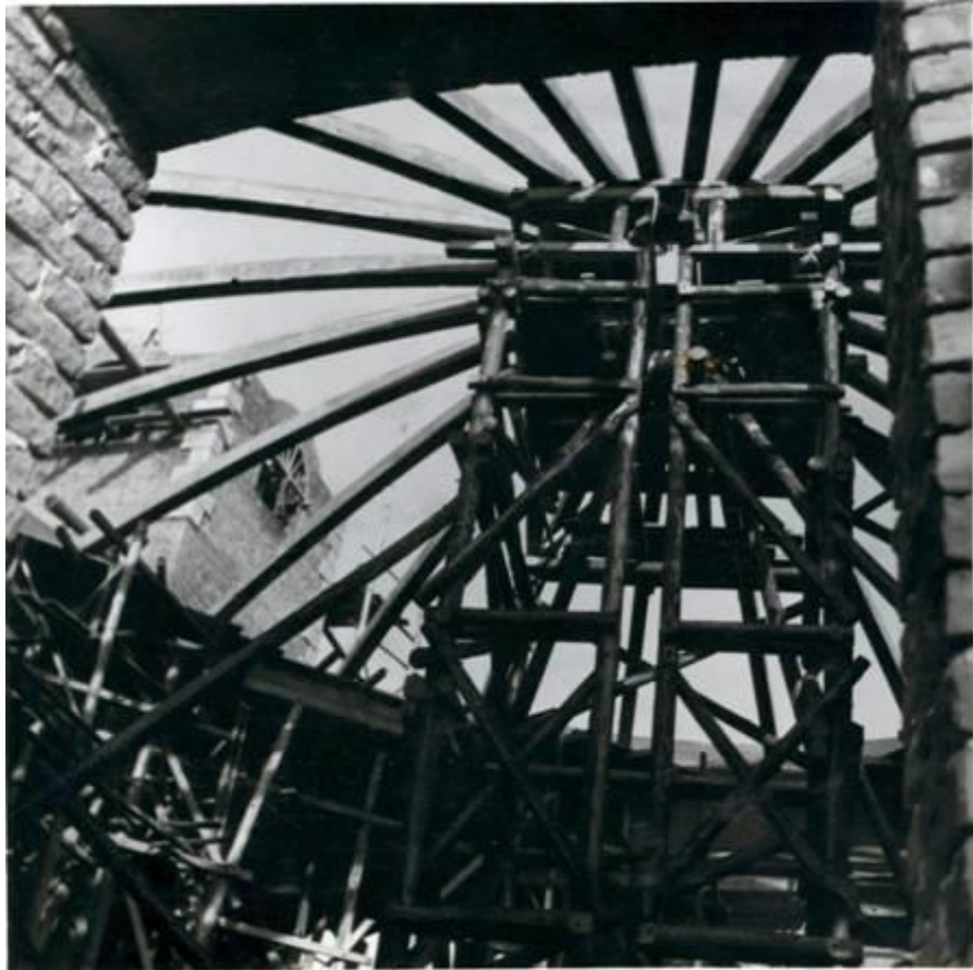
Lehrgerüst in der Kuppelmitte zum Auflegen der Stahlbeton - Fertigteilrippen.
