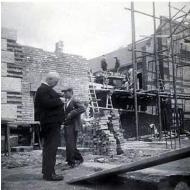
Errichtung der Außenmauer bei der Kirche.
