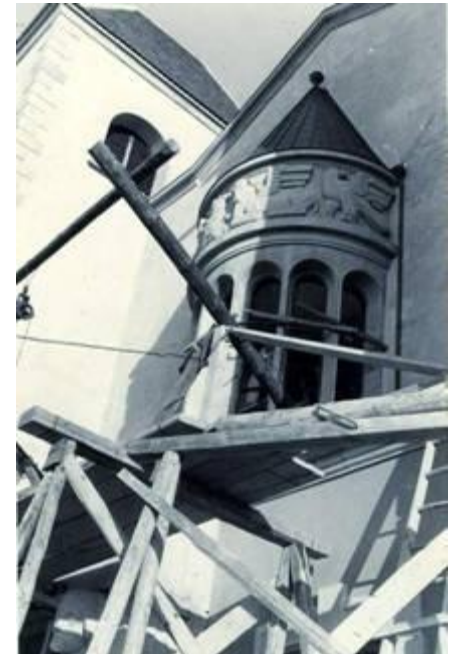
Verkleidungsarbeiten an der Chorfassade
